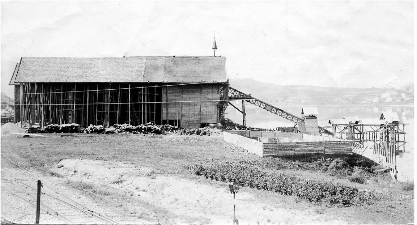
*Vue du dépôt N° 7, au nord de la glacière, lors du remplacement des colonnes-soutiens en bois par des éléments en béton, en 1895.*
