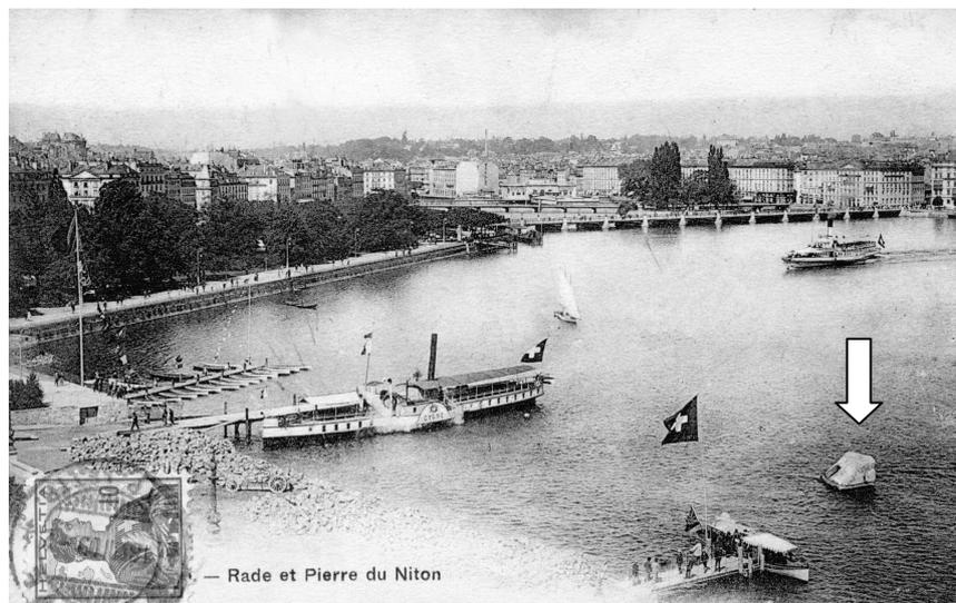
L'une des pierres sert de repère à toute l'hypsométrie suisse (mesure des altitudes). Le repère consiste en une plaque de bronze scellée par Dufour à 27 millimètres au-dessous du sommet du bloc. On l'appelle RPN, et il se situait alors à 376,64 mètres au-dessus du niveau de la mer. Mais en 1891, la Commission géodésique suisse l'a fixé à 373,54 mètres. On voit cette pierre à droite sur la photo ci-contre.
