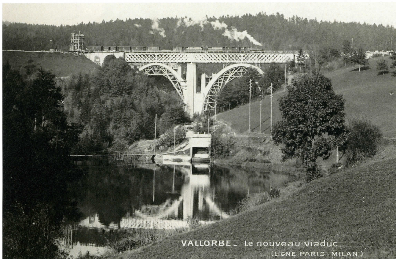
Viaduc du Day sur l'Orbe, près de Vallorbe. Construction des arches en maçonnerie sous le tablier métallique de l'ancien pont, 1924-25.
